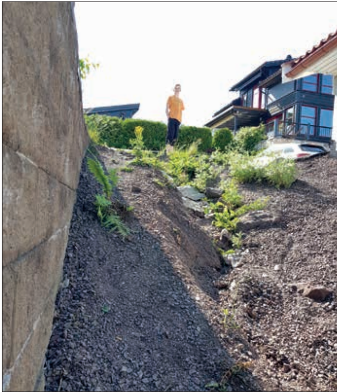
Den gamle trappa opp til Hans Heyerdahls vei er revet. Ny grov, erosjonssikker pukk skal legges ut i skråningen og ny trapp skal etableres.
